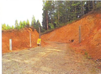
写真③ 朝日沢林道終点
